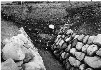
▲SD2700 部分写真。直径約30cmの玉石が、7段に積み上げられる。(南から)
