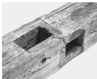
Fig. 193 北西隅柱新柄穴と横棧圧痕
