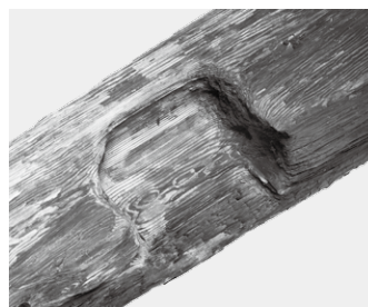
Fig. 195 南東隅柱旧仕口
