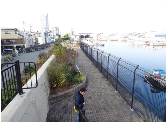
石材を設置している伝法漁港
