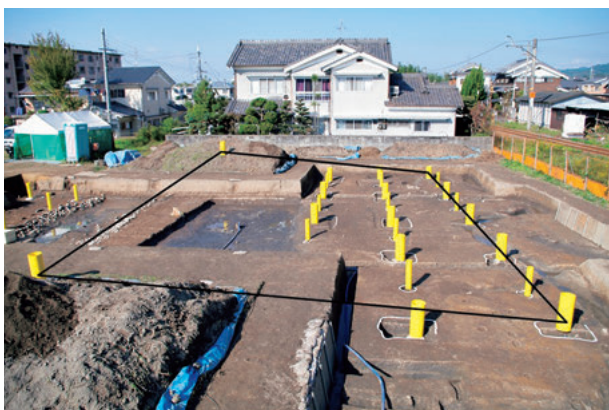
図4 建物Dの様子(南より)
