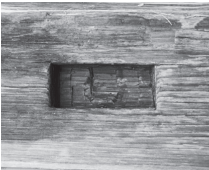
図241 太枘穴のノミ痕跡
