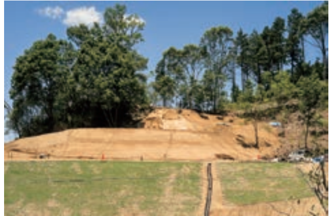
墳丘下斜面部の盛土造成 平成27年6月4日
