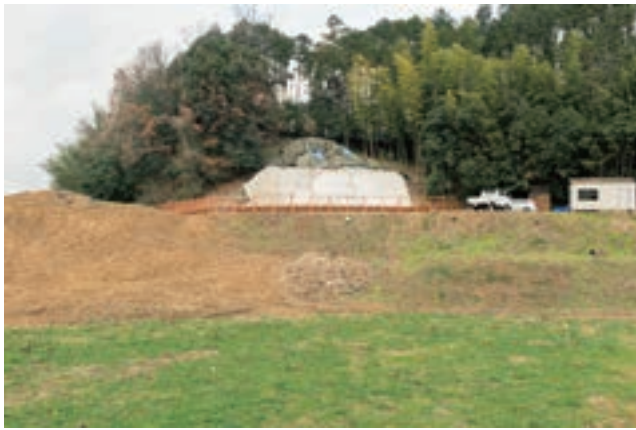
仮設保護覆屋の撤去 平成27年1月9日
