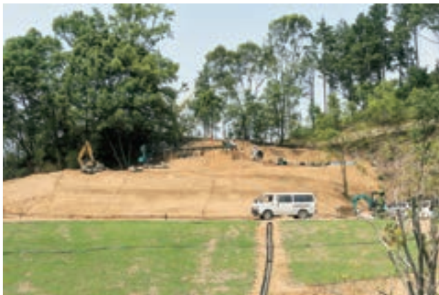
墳丘の盛土造成 平成27年6月12日
