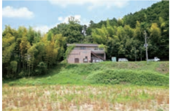
平成15年に設置した仮設保護覆屋 平成25年7月8日
