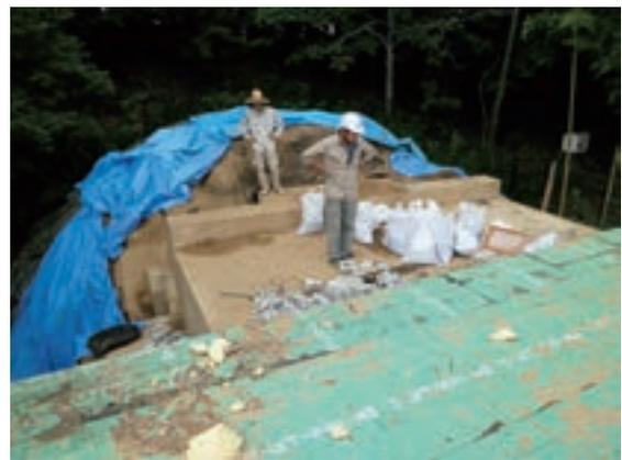
Fig.47 小前室天井の支障盛土掘削後
