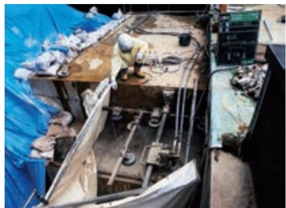
Fig.49 スラブ西側側壁 分離切断
