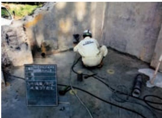
Fig.54 機械室側壁 水抜きコア削孔作業
