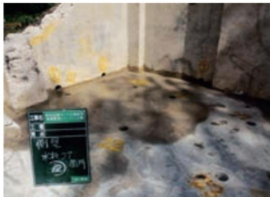
Fig.55 機械室側壁 水抜きコア削孔状況
