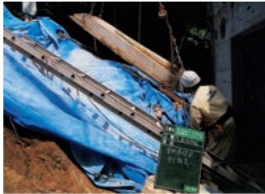
Fig.51 東側基礎吊り上げ撤去
