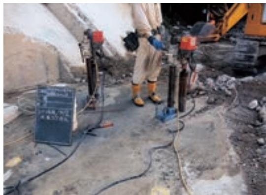
Fig.53 機械室床盤 水抜きコア削孔作業
