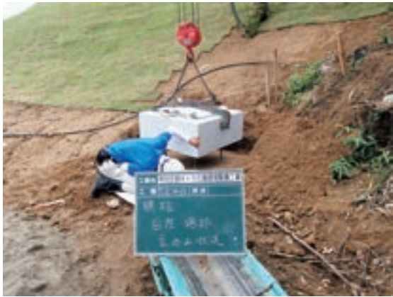
Fig.150 標識台座の設置
