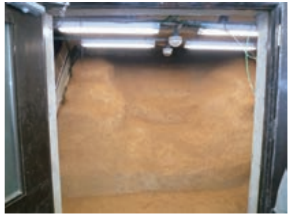
Fig.38 版築盛土完成
