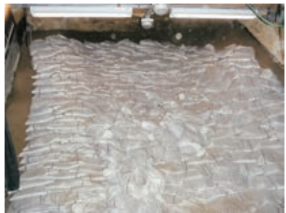
Fig.40 土のう養生の完了
