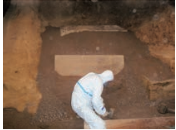
Fig.36 版築盛土作業
