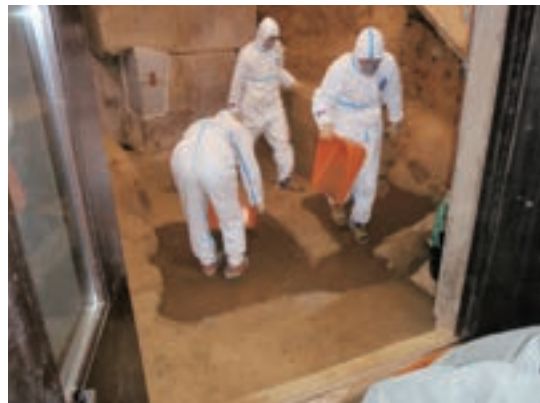
Fig.32 まき出し作業
