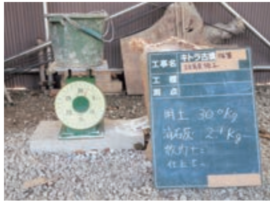
Fig.28 試験施工での材料の配合②
