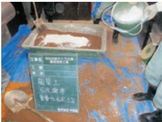
Fig.33 消石灰混合作業
