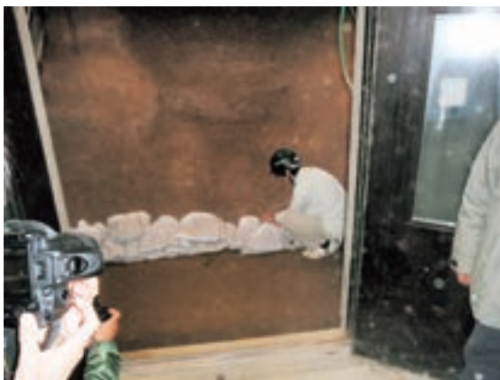
Fig.39 土のう養生の開始
