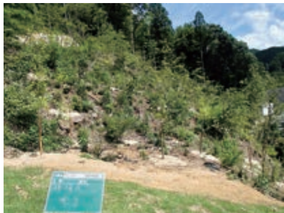
Fig.138 補植A施工完了
