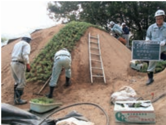
Fig.134 コグマザサ施工状況
