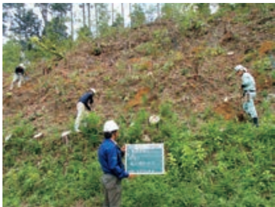
Fig.137 補植A施工状況
