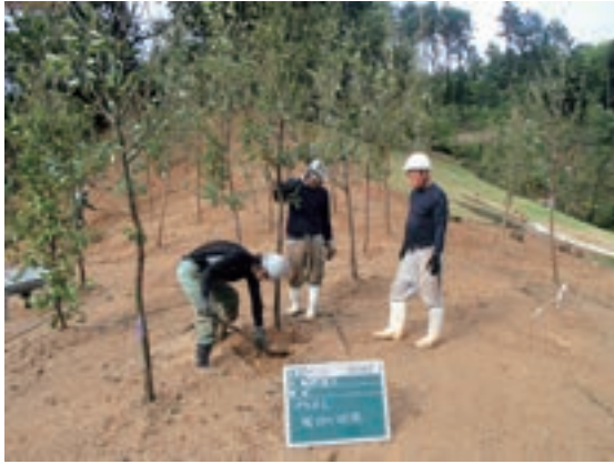
Fig.139 補植B施工状況
