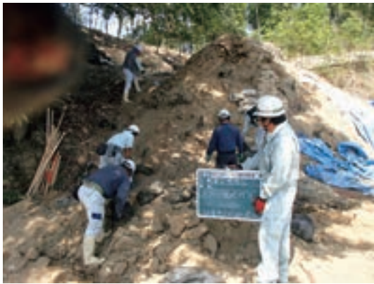
Fig.94 土のう撤去状況
