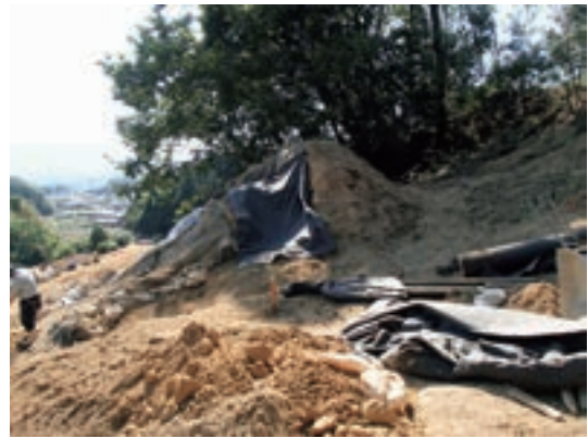
Fig.95 土のう・不織布撤去状況
