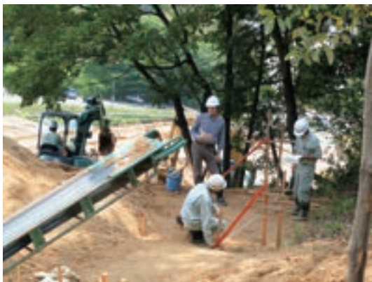
Fig.100 背面カット部の丁張り
