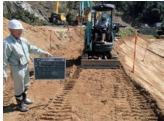
Fig.84 盛土造成作業
