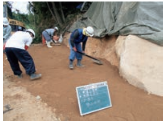
Fig.97 人力盛土施工
