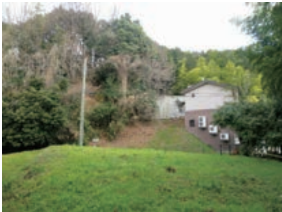
Fig.81 崩落頻発地（ミラー付近）西から
