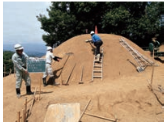
Fig.99 盛土整形作業
