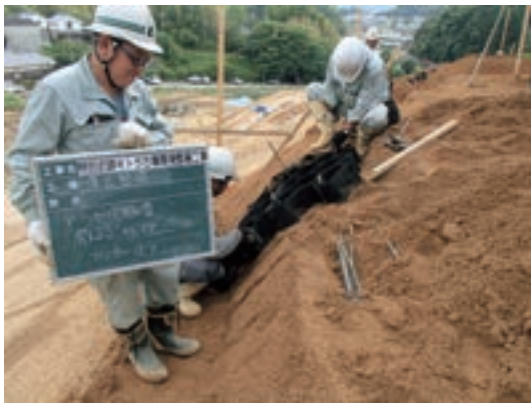
Fig.98 墳丘下段部テラセル設置状況
