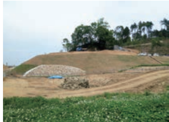
Fig.86 園路地盤完成
