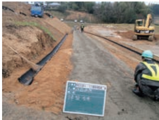
Fig.61 路盤施工中
