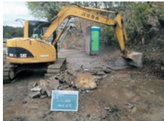
Fig.77 コンクリート舗装撤去状況
