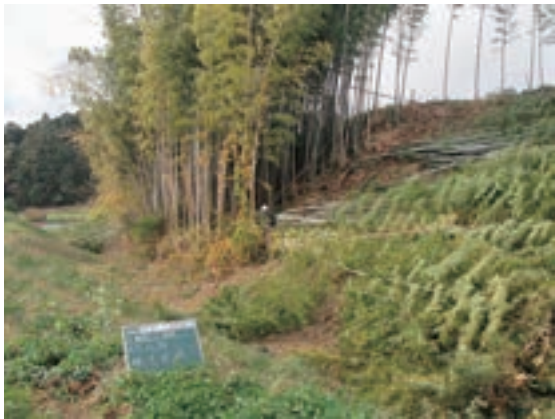
Fig.67 南西部伐開施工状況
