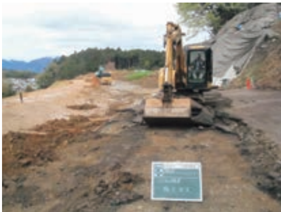
Fig.76 アスファルト舗装撤去状況
