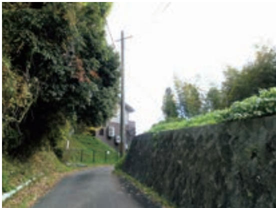
Fig.74 アスファルト撤去前の状況（墳丘西側）
