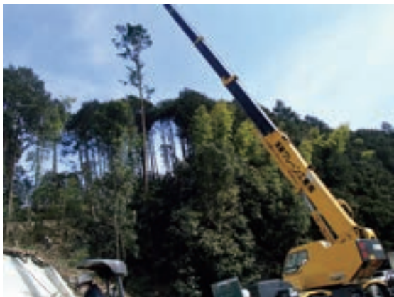
Fig.71 クレーンを用いた伐開作業
