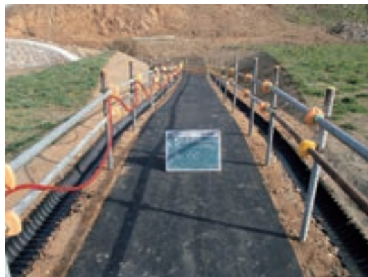
Fig.65 工事完了 (南から)
