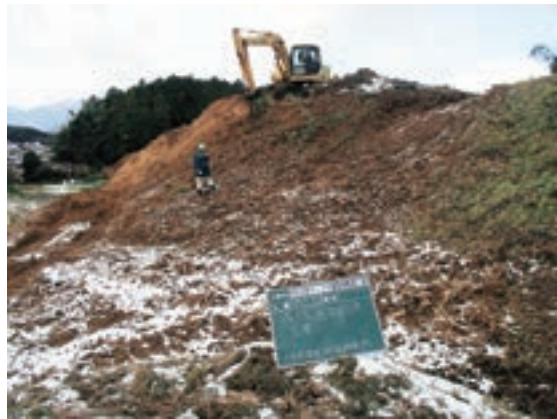
Fig.68 南西部竹伐根施工状況
