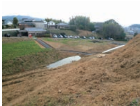
Fig.63 仮設通路・遠景
