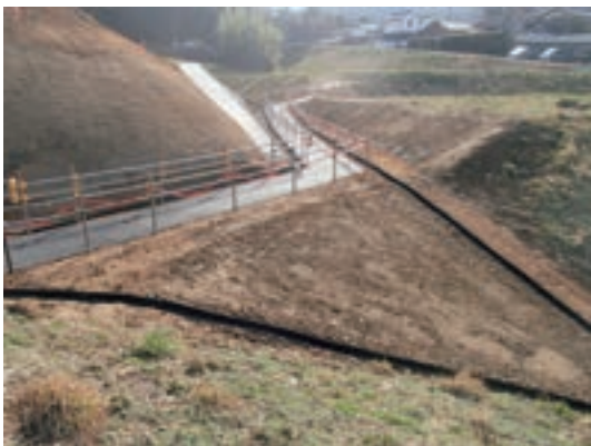
Fig.64 工事完了 (北から)
