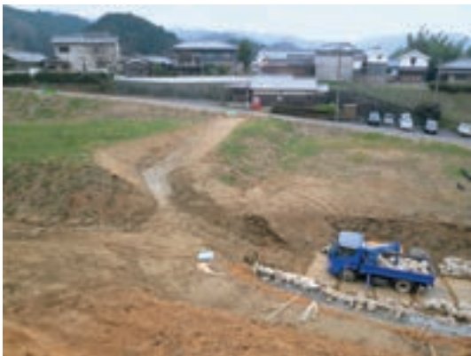
Fig.60 仮設通路造成中
