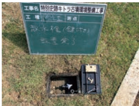
Fig.173 散水栓設置完了
