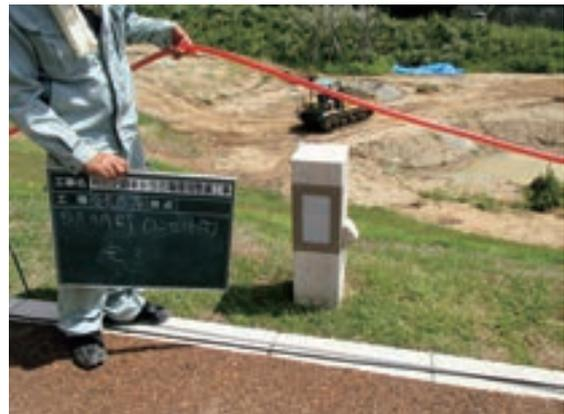
Fig.178 照明灯防水コンセント付
