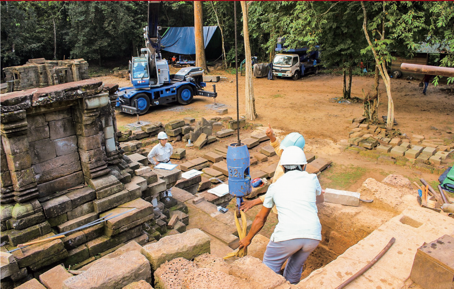
カンボジア：西トップ遺跡中央祠堂 砂岩基壇外装の解体 Cambodia: Dismantling the sandstone facing of the podium, Central Shrine at Western Prasat Top
