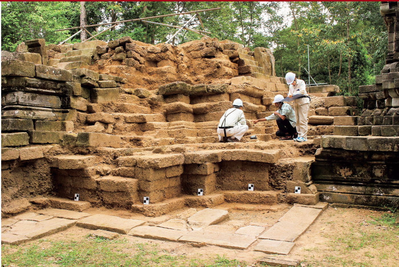
カンボジア - 西トップ遺跡中央祠堂ラテライト基壇の調査 Investigation of a laterite podium, Central Shrine at Western Prasat Top, Cambodia
