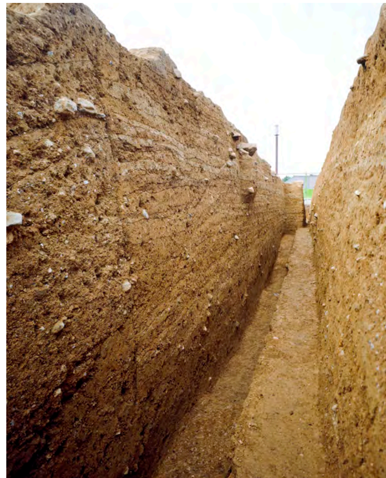
▲南大門の基壇版築層(南から)
