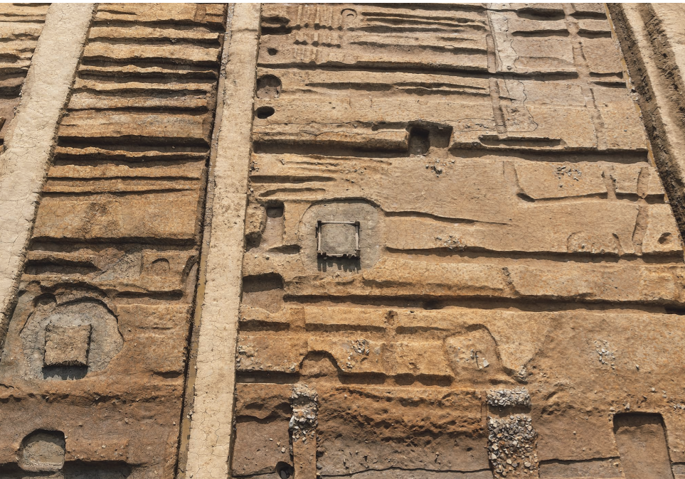
東面北回廊（手前）と大極殿後方東回廊（東から） ※大極殿後方東回廊が取り付く2間分（写真中央）は柱間寸法を狭くする
