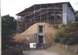
▲調査用覆屋の建設風景
