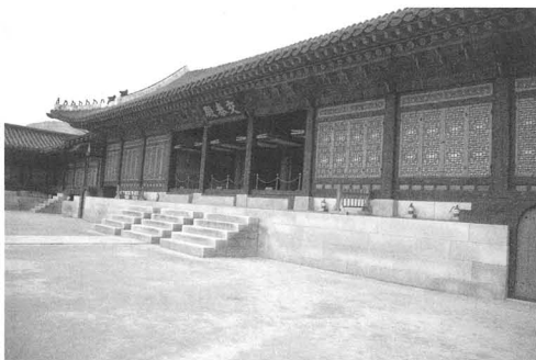
第9図 韓国の建物復元事例（景福宮交泰殿）
