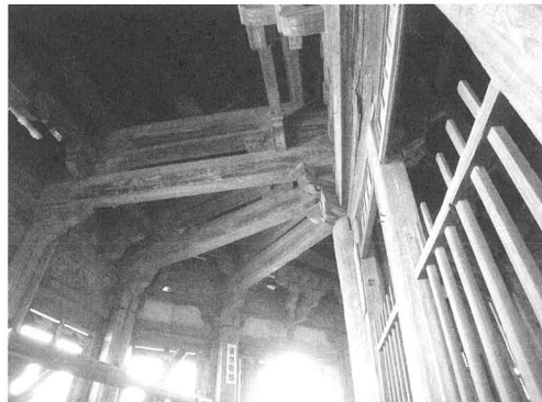
第 27 図 応県木塔の二重内部の構造 (筆者撮影)
