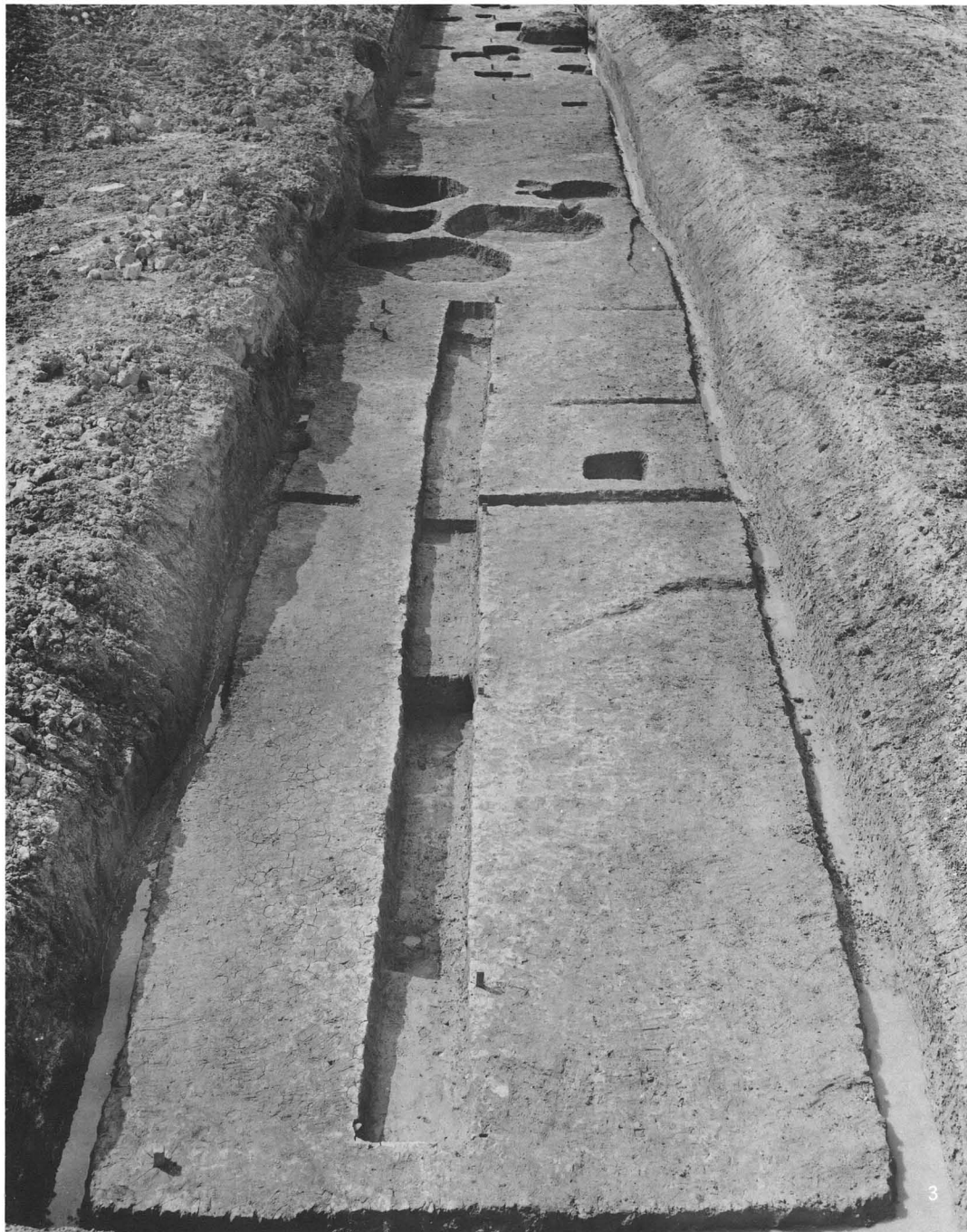
1 二坊大路西側溝(SD1000) 北から 2・3 東西小路(SX1060) 北から
