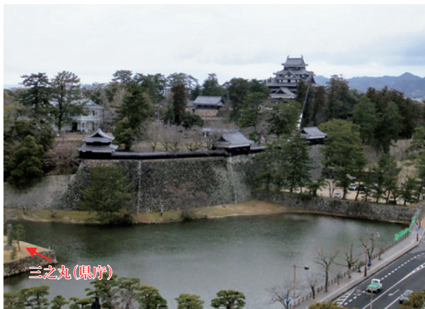
図8 史跡松江城 平成29年(2017)3月南東から北西方向を撮影
