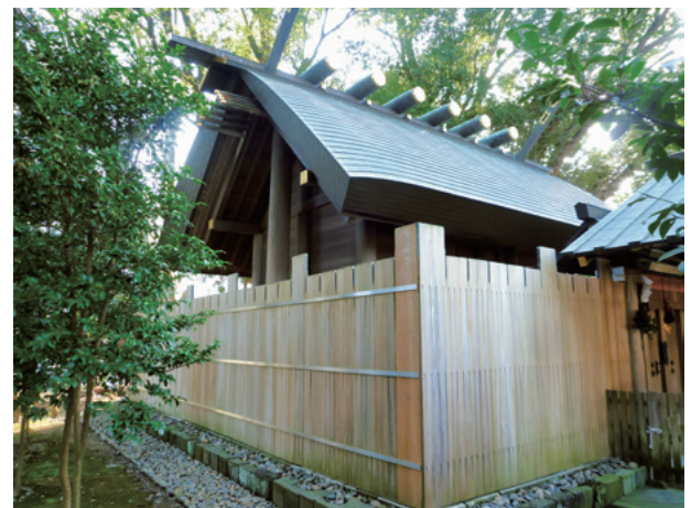
図4 特別史跡弘道館内の鹿島神社本殿
