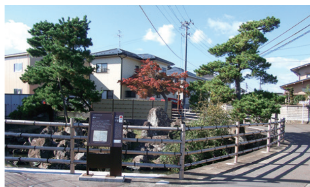
図8 デッキと竹垣風フェンスが設置された興井
