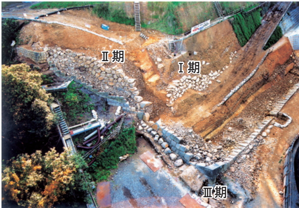
図4 本丸北壁石垣内部の旧石垣
