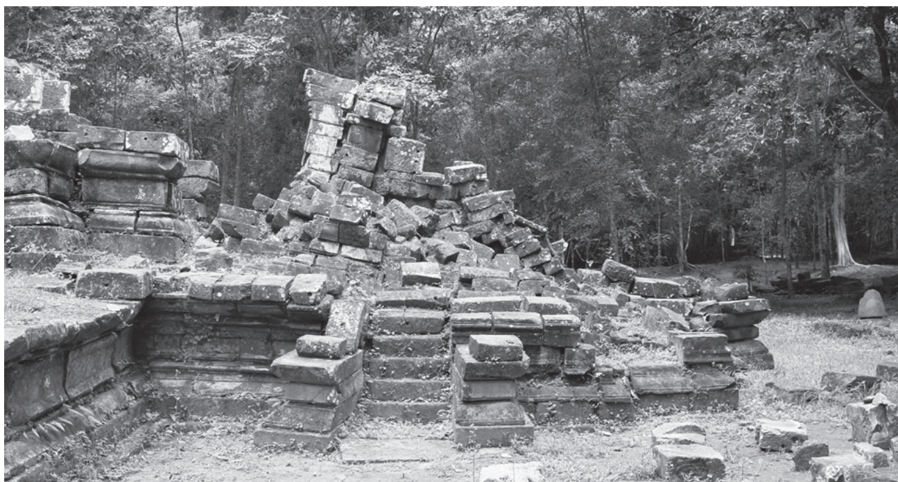
図6 北祠堂(東から)
