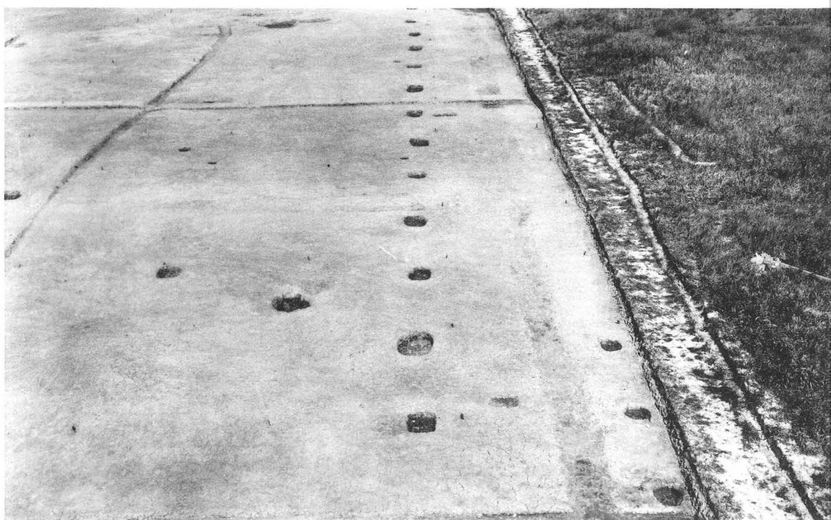
3. 塀 SA3740 西から
