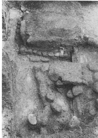
第11図 中門東南隅(左上)より回廊取付部付近に亘る基壇石
