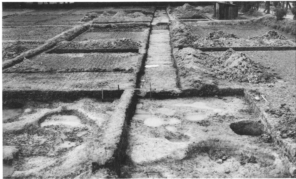
2. 収蔵庫建設予定地 東から
