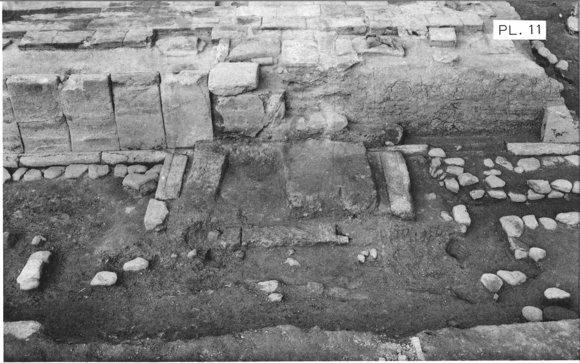
1. 南面階段(東) 南から
