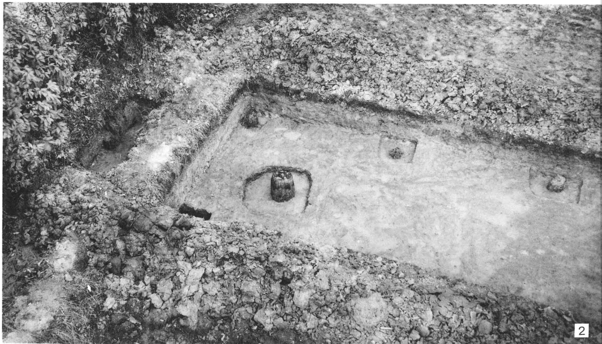
2. 収蔵庫建設予定地 東南から
