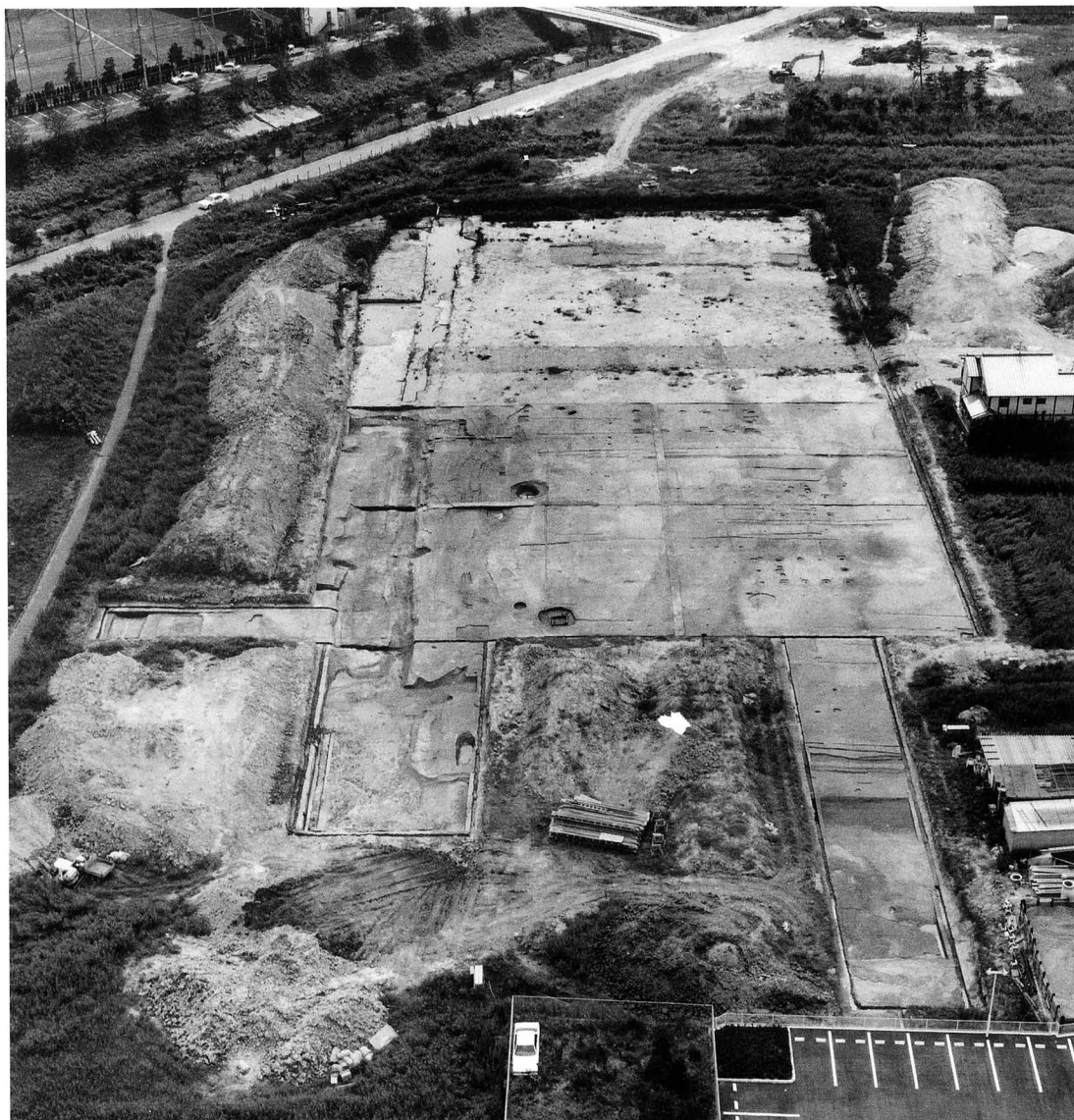
1 調査区全景 北上空から
