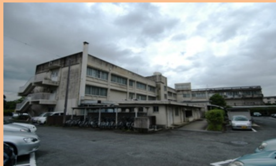
②外観全景 西面(背面)
