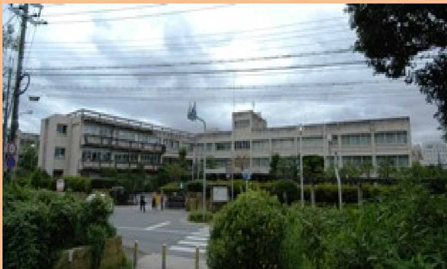
①外観全景 東面(正面)
