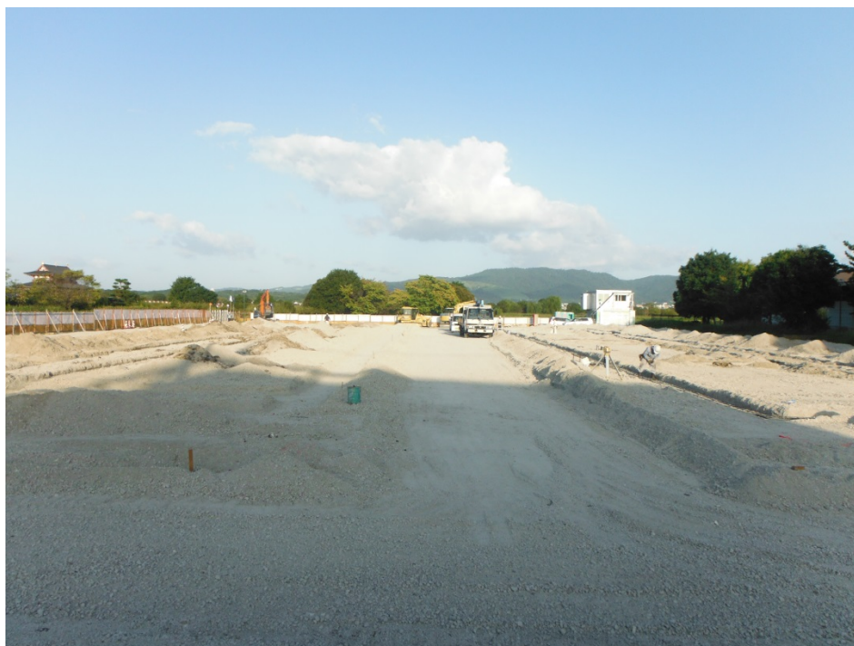
仮設庁舎設置現場 (H25. 9. 24 佐伯門方向より撮影)
