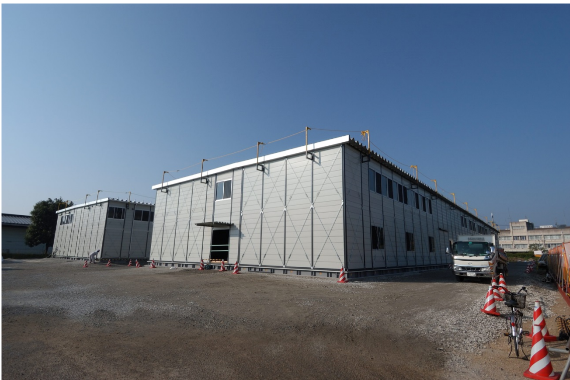
建物屋根・外壁完成
