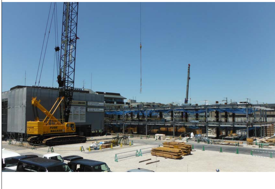
北棟1・2階躯体工事状況 (平成29年5月)
