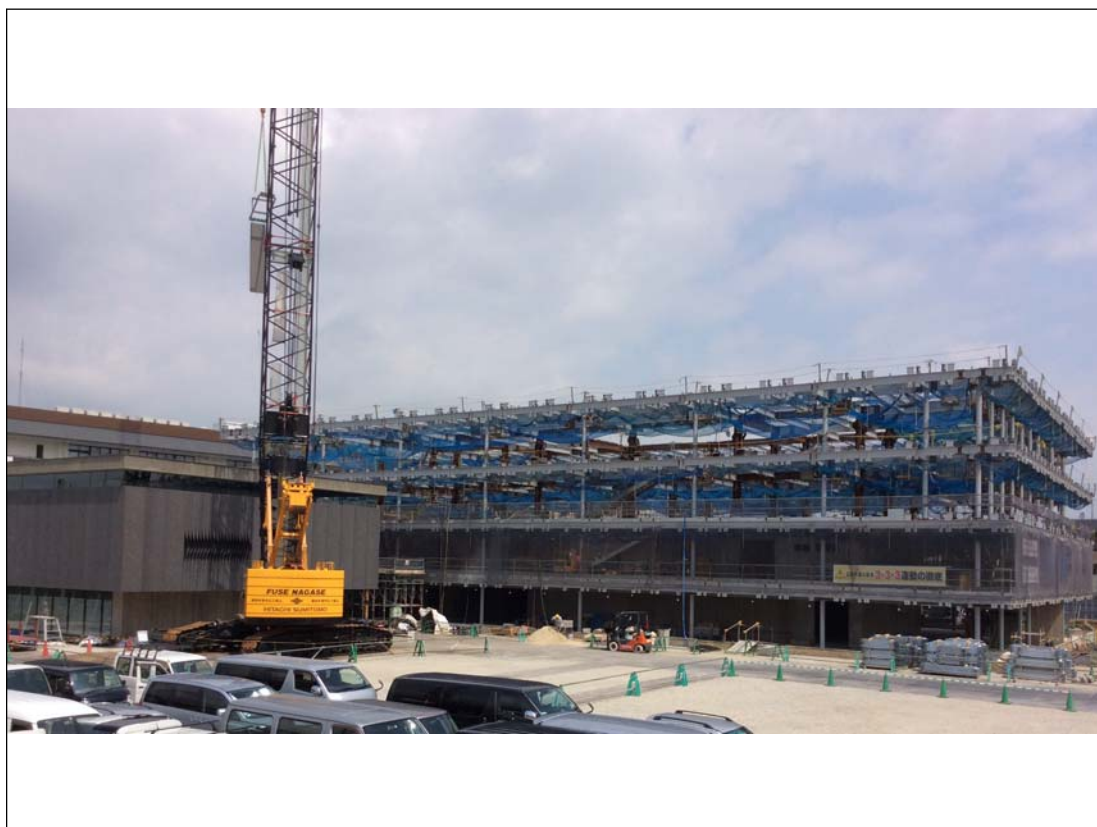
南棟外装仕上工事、北棟3・4階躯体工事状況 (平成29年7月)
