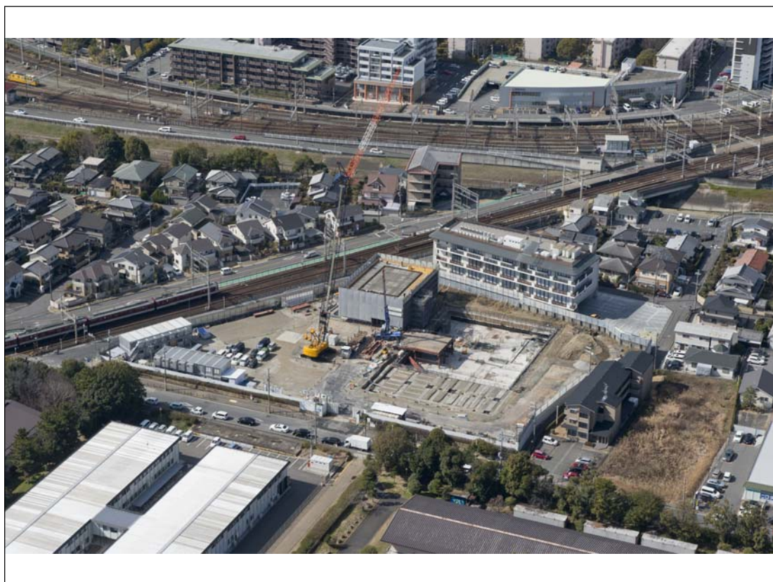
北棟地下・基礎躯体工事状況 (平成29年3月)
