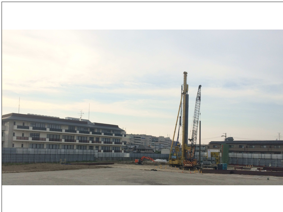
敷地状況 (平成28年5月)
