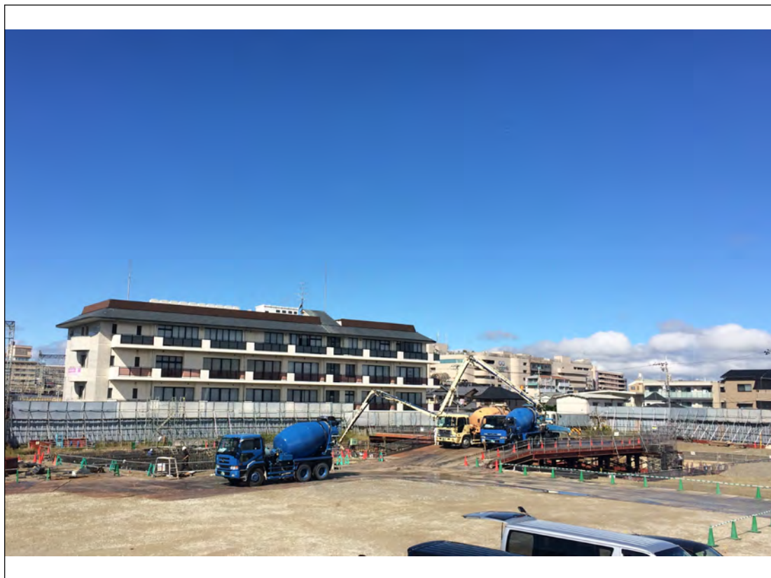
基礎工事状況 (平成28年10月)
