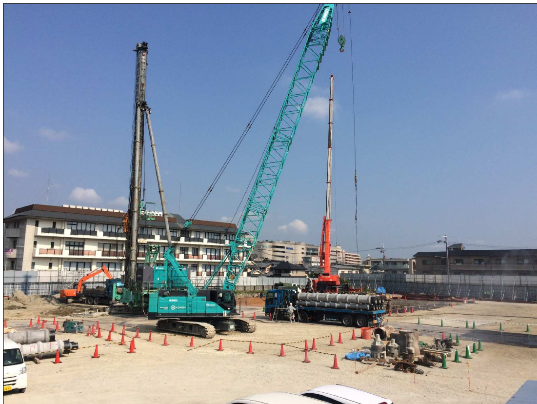
地下掘削及び杭工事状況 (平成28年8月)
