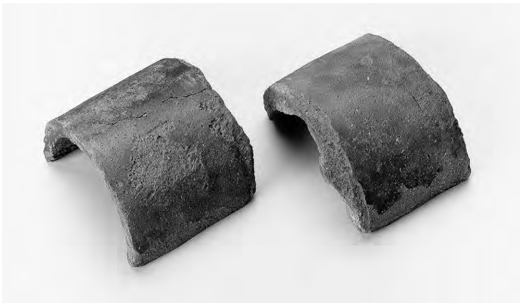
Fig.121 面戸瓦B I aの風化痕跡
