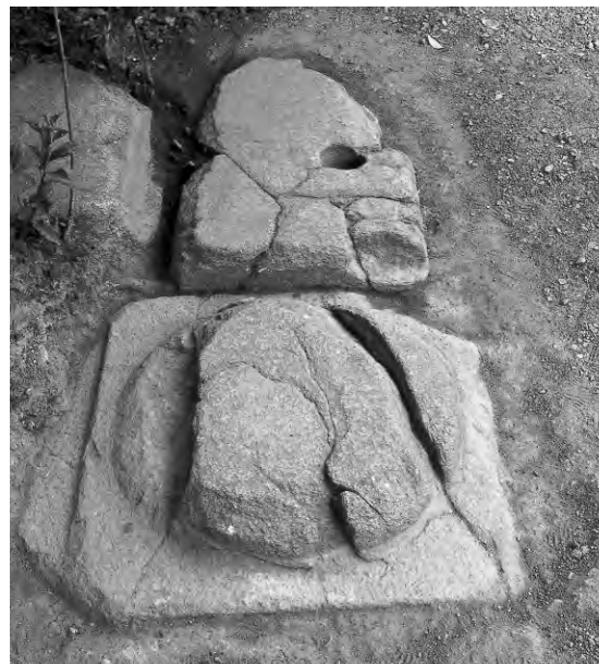
3 南側柱筋東から4個目の礎石と地覆石 西から
