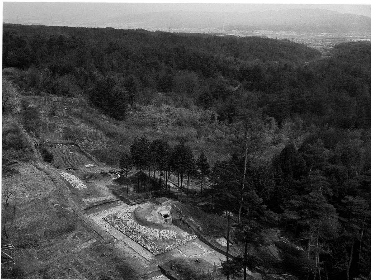
1 遠景 (南西上空から)
