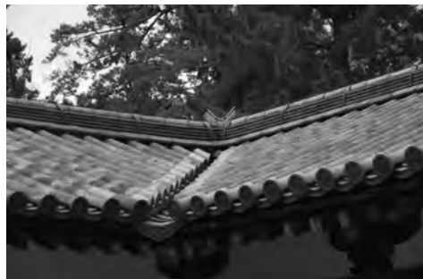
第13図 法隆寺西院伽藍回廊入隅の谷どい部
