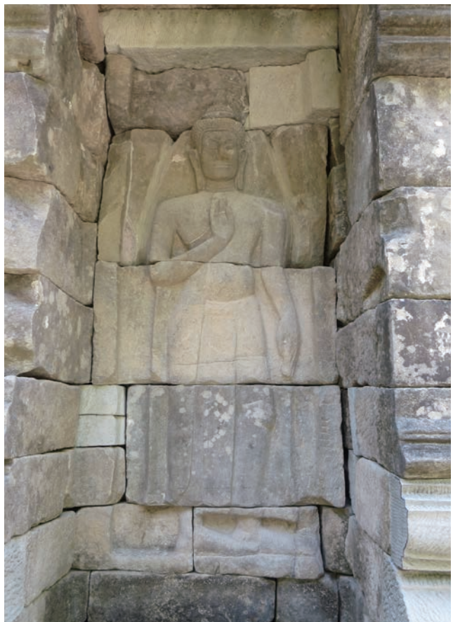
第16図 北祠堂西面偽扉再構築状況（西から）
