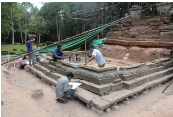
第14図 北祠堂下成基壇再構築作業風景（北西から）
