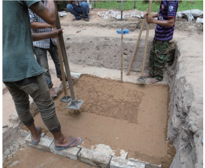
第8図 南祠堂再構築作業状況
