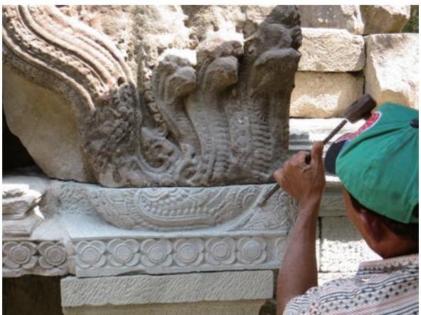
第15図 北祠堂ペディメント新材彫刻作業風景（東から）
