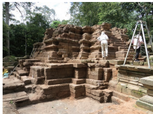
第22図 中央祠堂ラテライト基壇調査風景(北東から)
