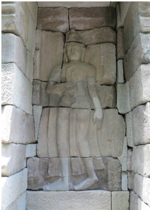
第 18 図 北祠堂北面偽扉再構築状況（北から）
