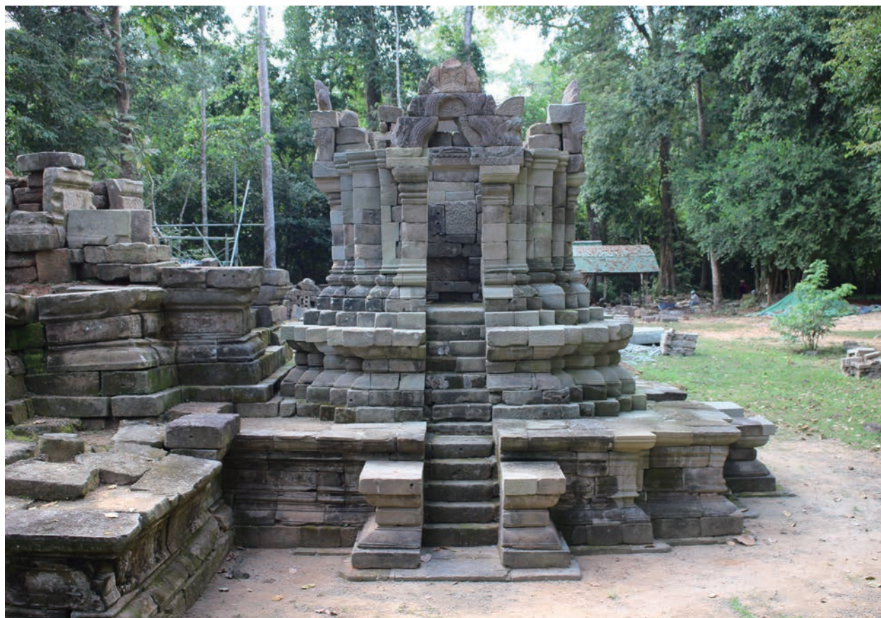
第 19 図 北祠堂再構築状況（東から）
