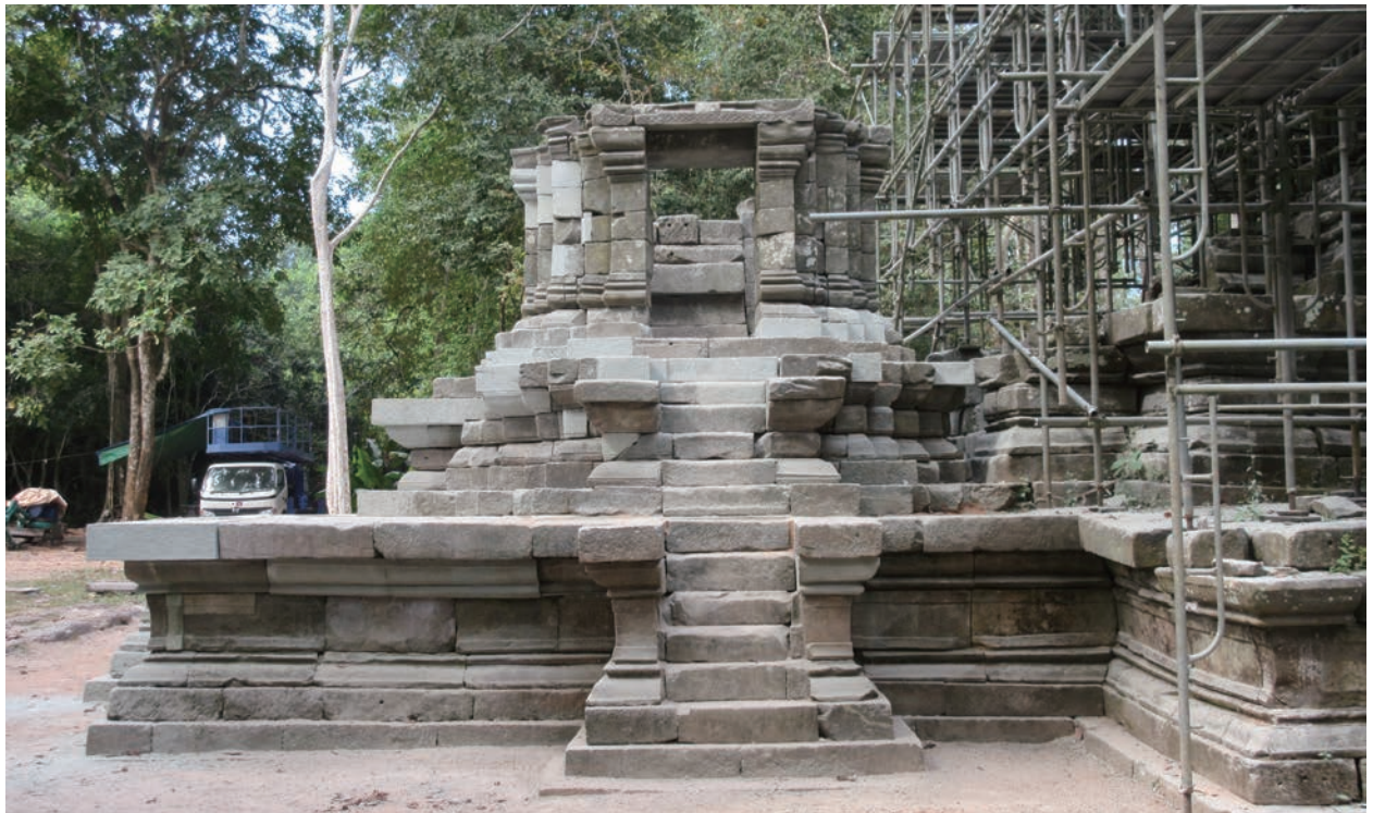
第9図 南祠堂再構築状況(東から)
