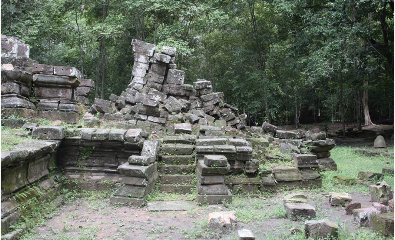
第10図 北祠堂修復前状況（東から）
