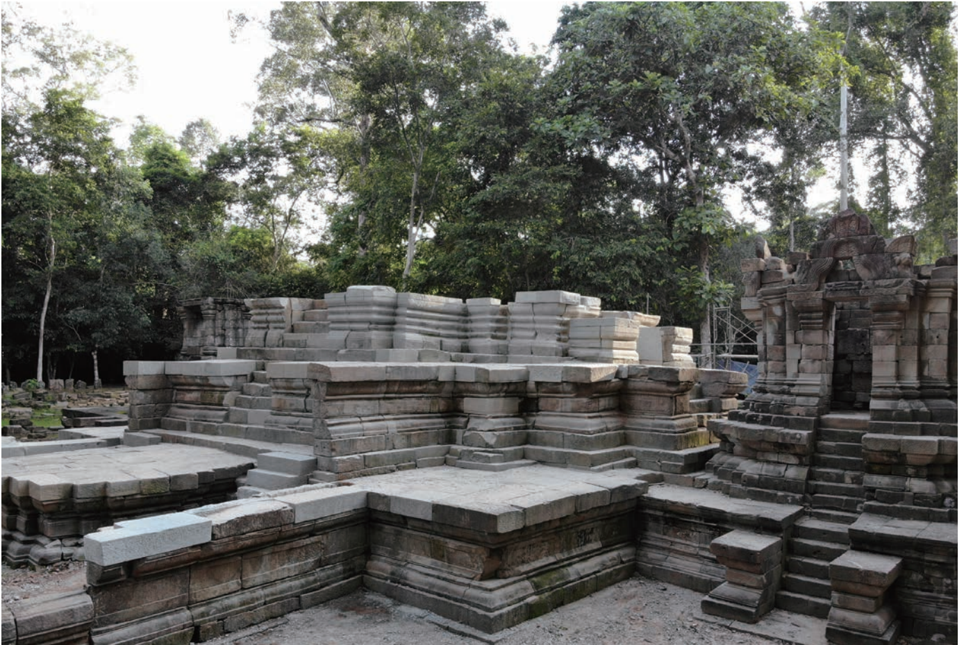
第 27 図 中央祠堂基壇再構築状況（北東から）
