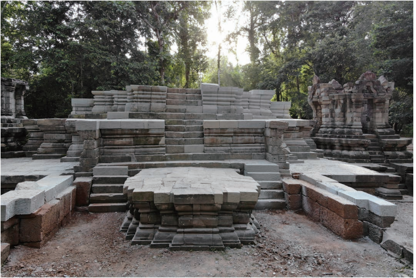
第 26 図 中央祠堂基壇再構築状況（東から）
