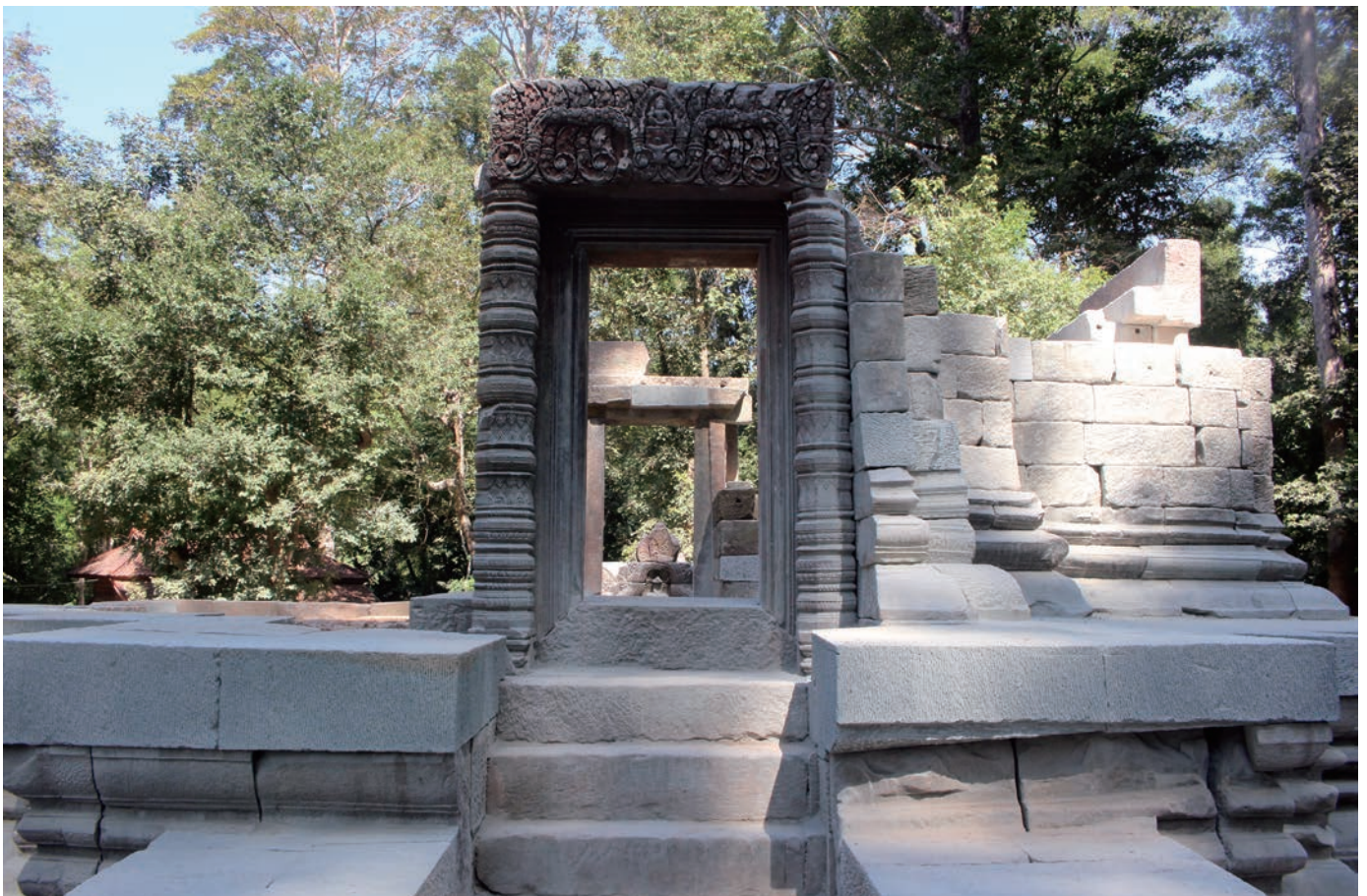
第 31 図 中央祠堂躯体部扉枠再構築状況（南から）
