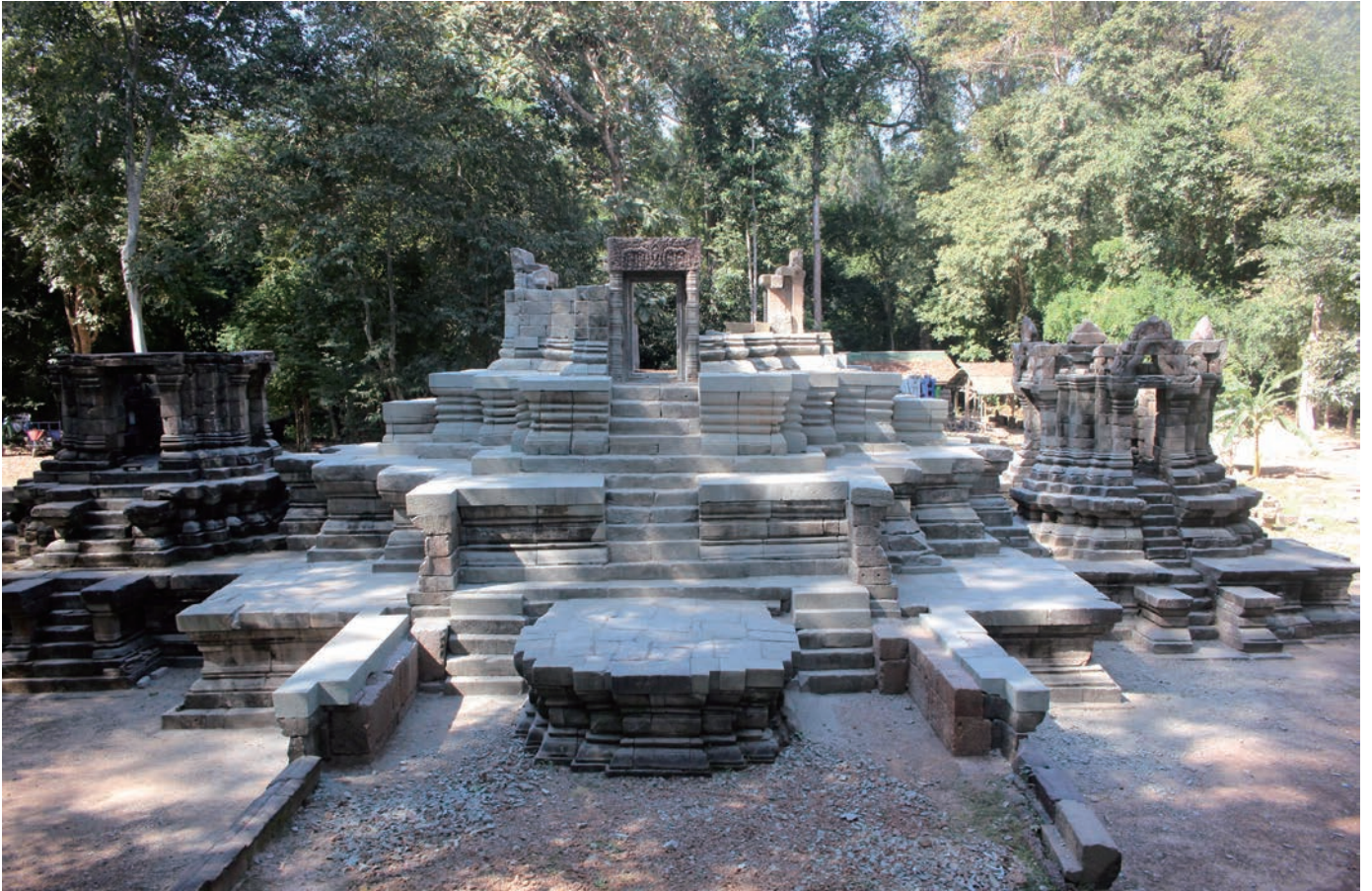
第 28 図 中央祠堂基壇部・躯体部再構築状況（東から）
