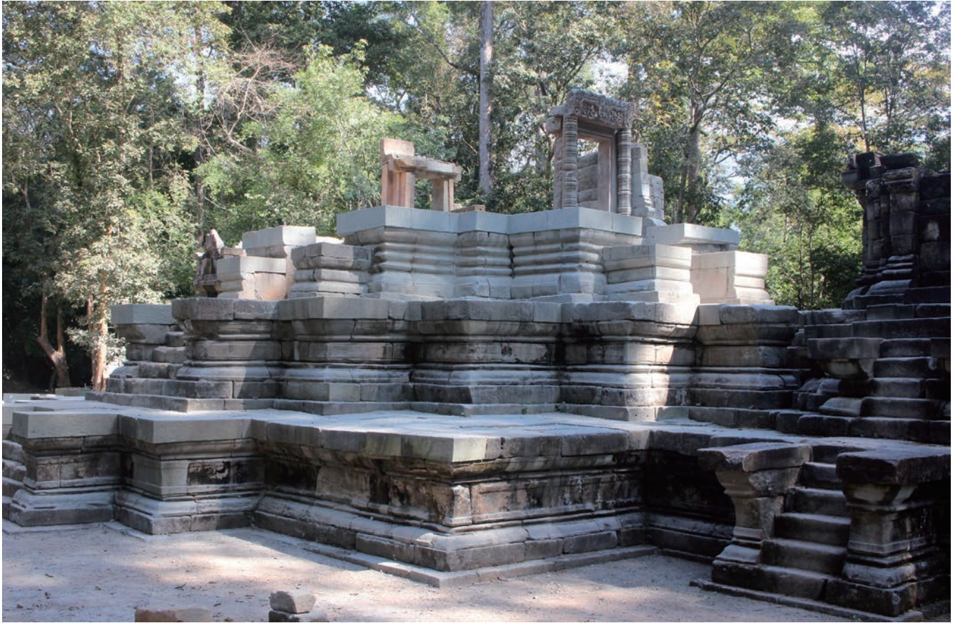
第 30 図 中央祠堂躯体部扉枠再構築状況（南西から）
