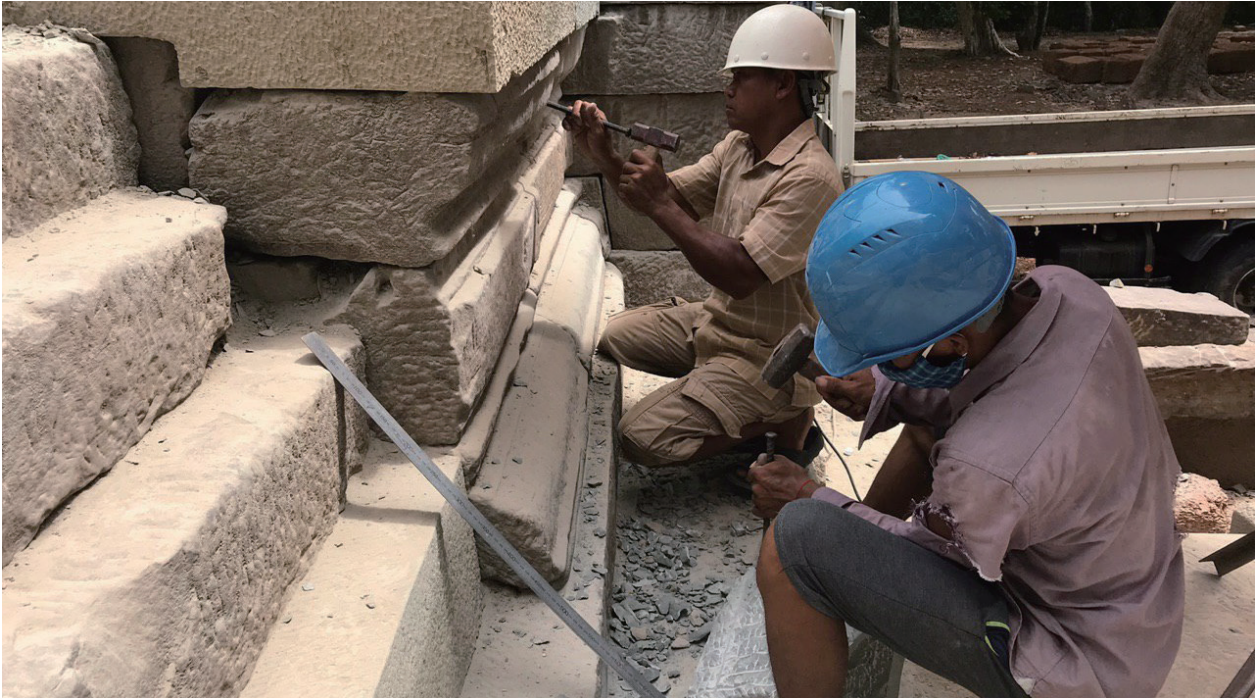
第24図 中央祠堂基壇再構築作業風景
