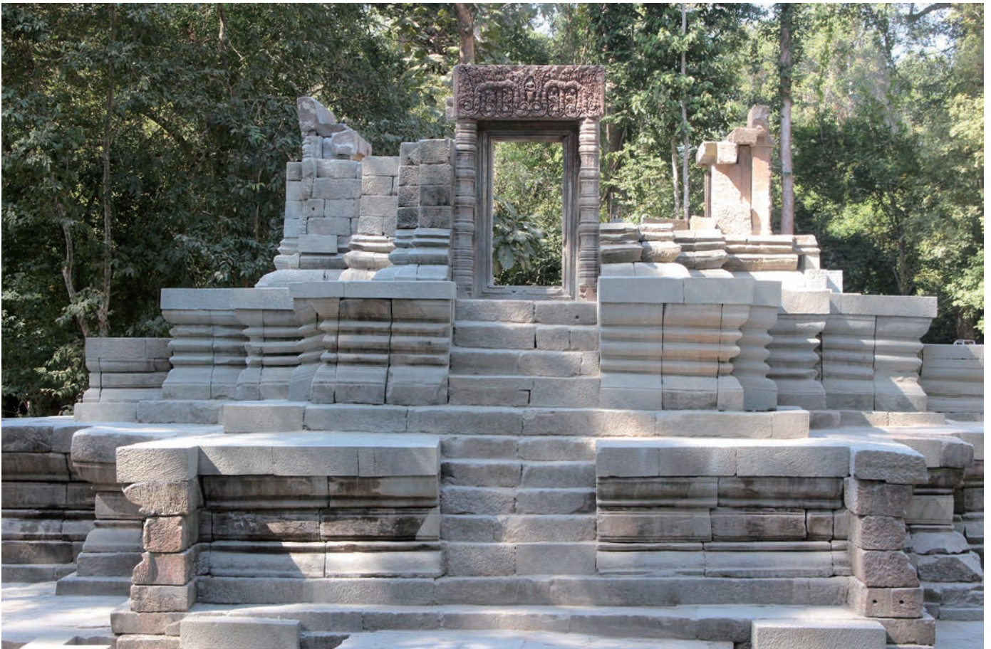
第 29 図 中央祠堂躯体部扉枠再構築状況（東から）
