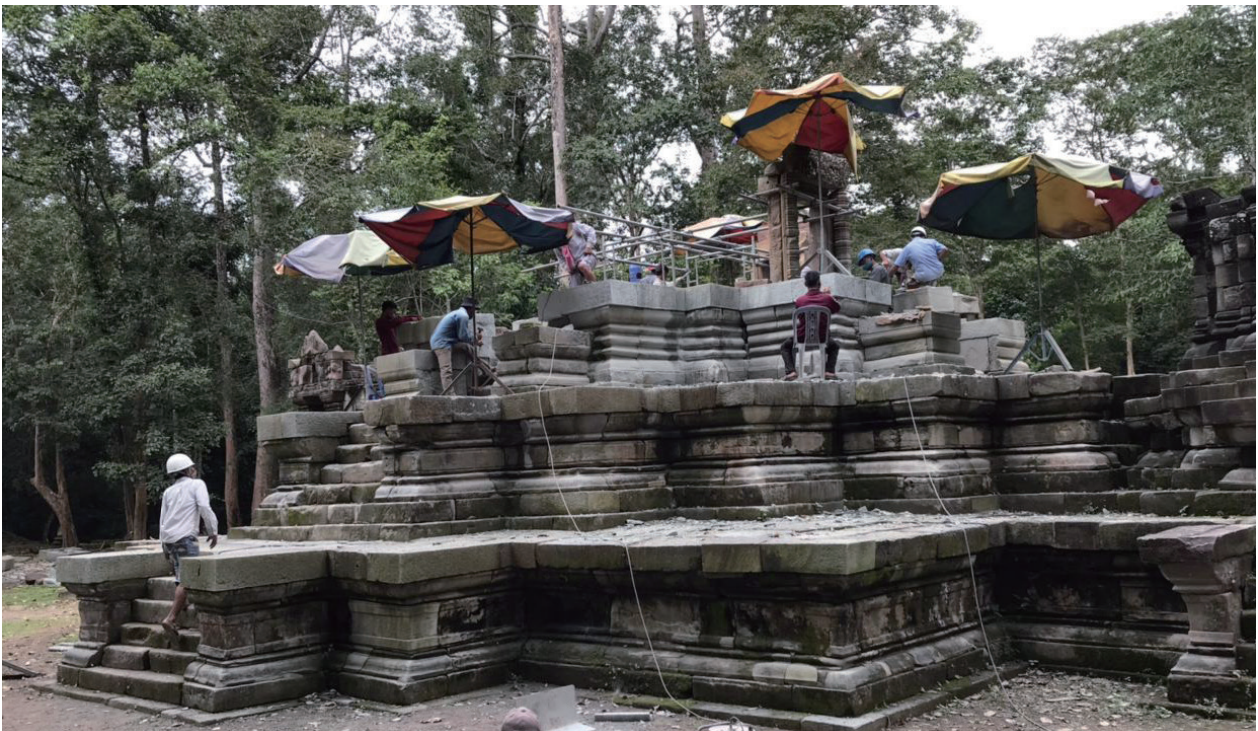
第25図 中央祠堂基壇再構築作業風景
