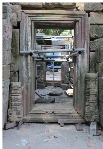
Fig.6 東面扉枠 (仮組中)
