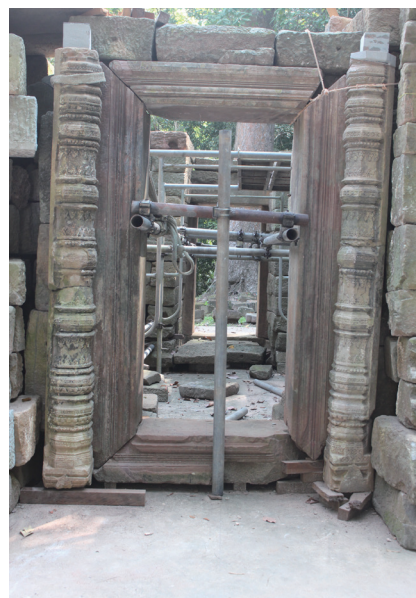
Fig.7 西面扉枠 (仮組中)
