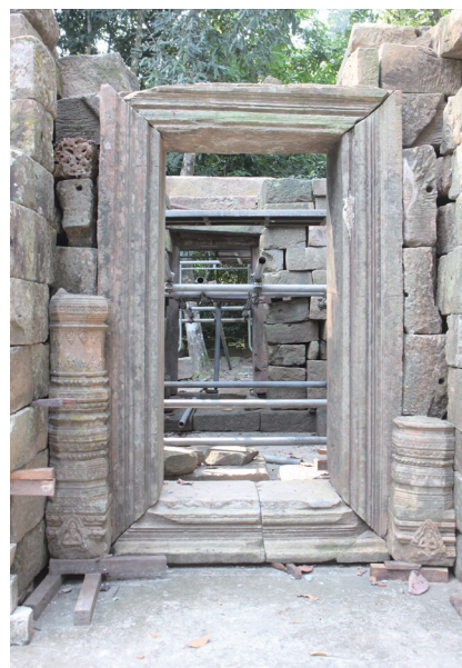
Fig.8 北面扉枠 (仮組中)
