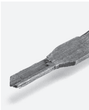
図77 4・5の接合状況
