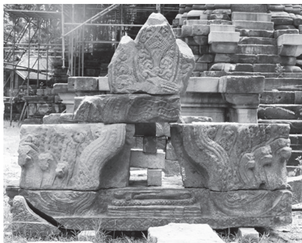
図15 西面破風仮組状況
