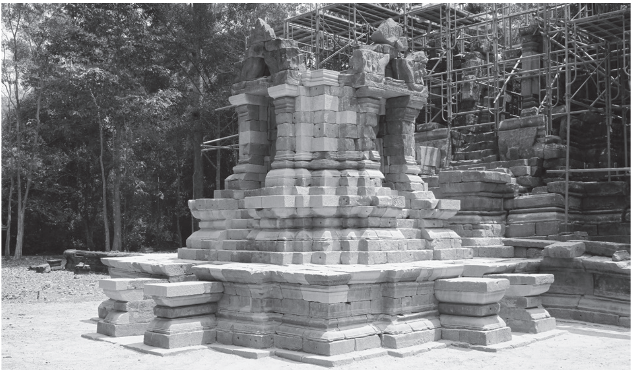
図14 北祠堂修復完成後（北西から）
