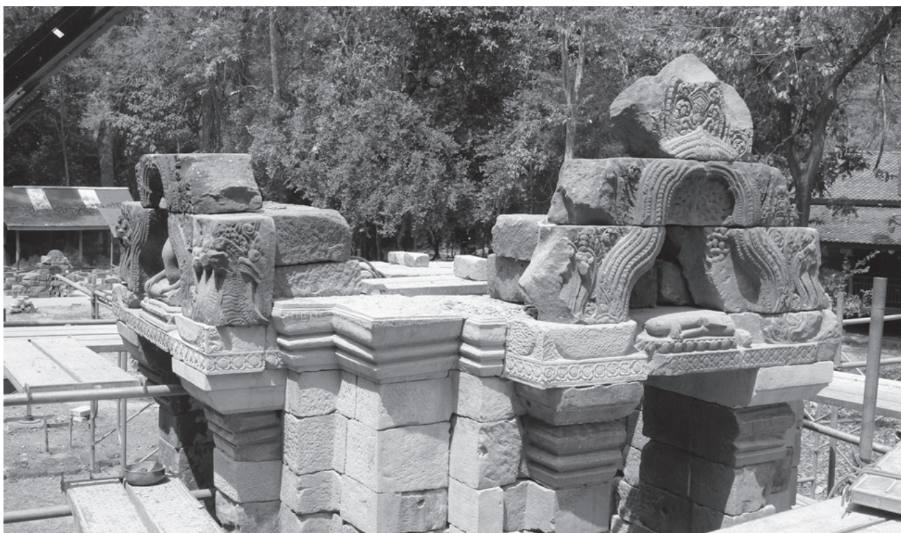
図16 破風組み上げ状況 (南東から)
