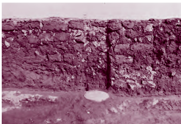
7. 附属建物F3主室東壁の壁柱 (西から)
