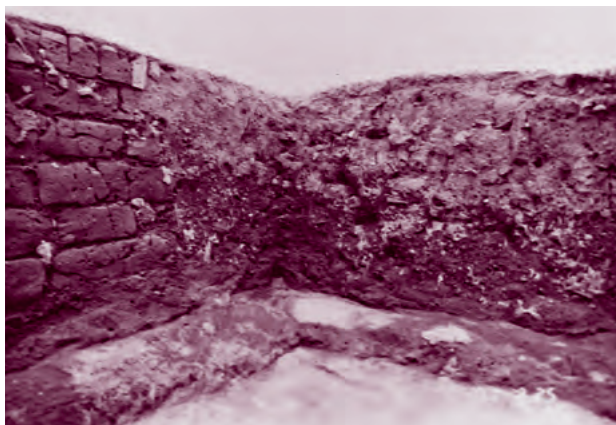
4. 附属建物F3主室西南隅柱 (北東から)
