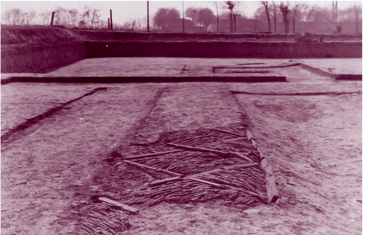
2. 1号院南面廊道北側雨落 (東から)
