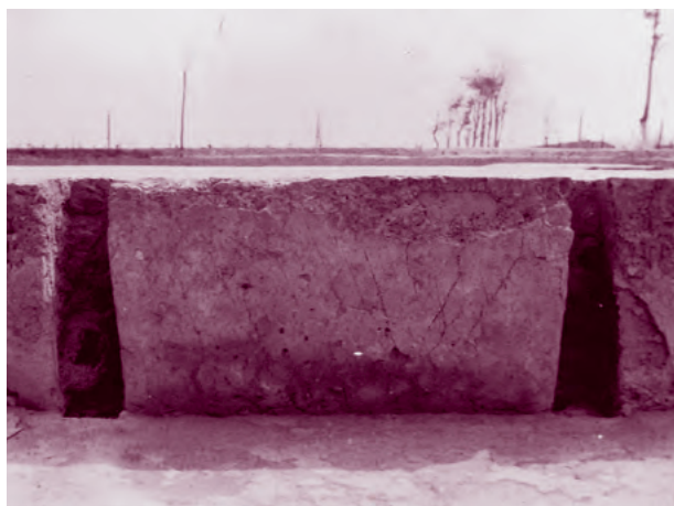
2. 附属建物F2主室東壁の筋(西から)
