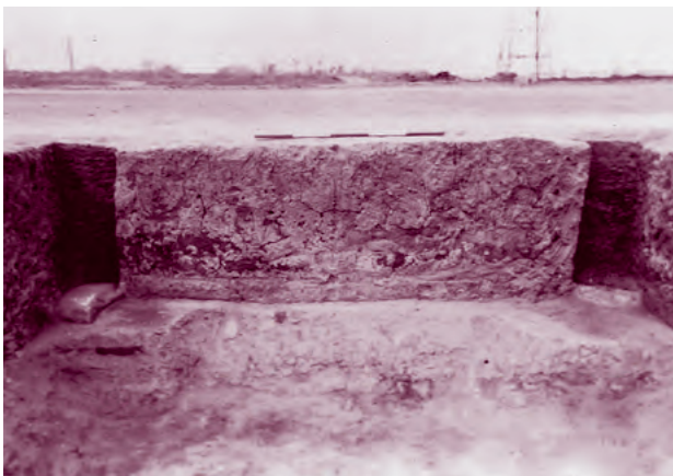
6. 附属建物F2主室北壁 (南から)
