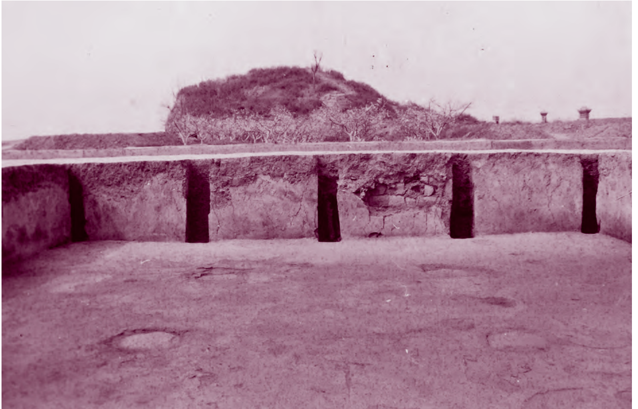
1. 附属建物F2主室北壁(南から)
