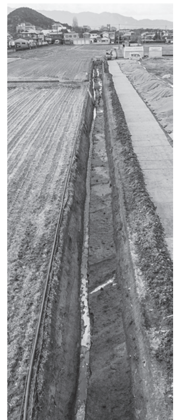
図101 第192-7次調査区全景(東から)
