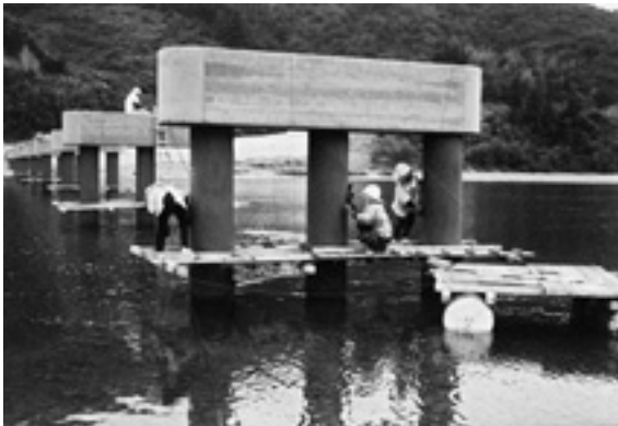
図4-58 橋脚設置後の高瀬橋（四万十市高瀬）
