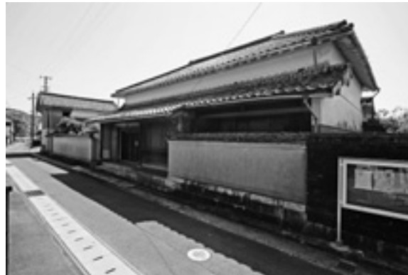
図4-97 森山家住宅主屋正面(北東から)
