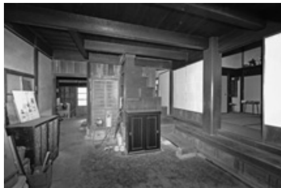
図4-99 森山家住宅奥の土間
