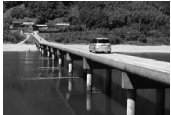
図4-59 現在の高瀬橋
