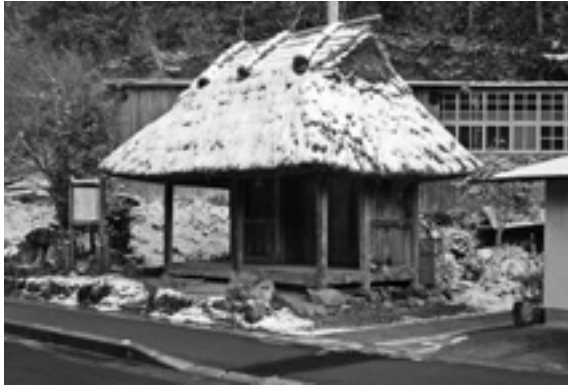
図4-3 川西路の茶堂全景
