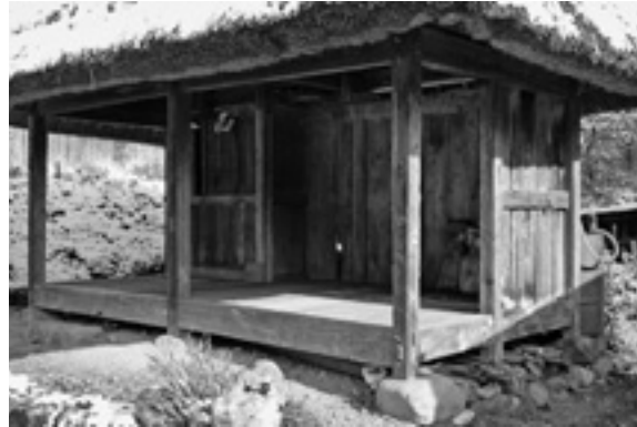
図4-5 川西路の茶堂内部
