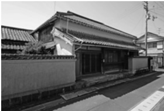
図4-96 森山家住宅主屋正面(南東から)
