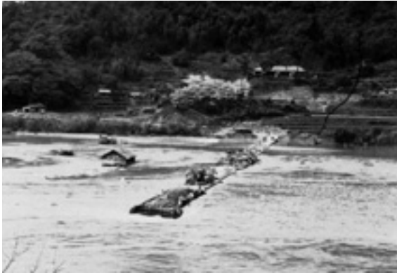
図4-56 架橋中の屋内大橋
