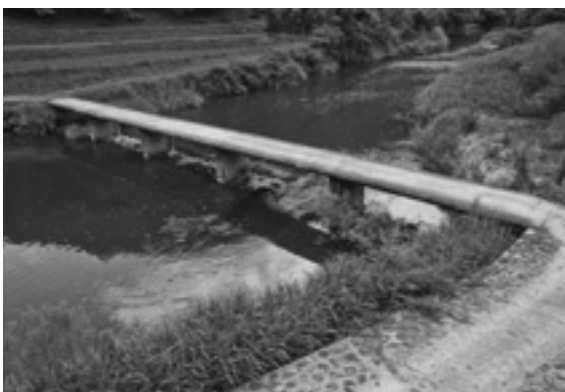
図4-60 旧高樋堰を利用した本流最上流の沈下橋
