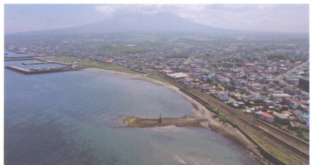
写真2 森栈橋跡俯瞰（北西から撮影）
