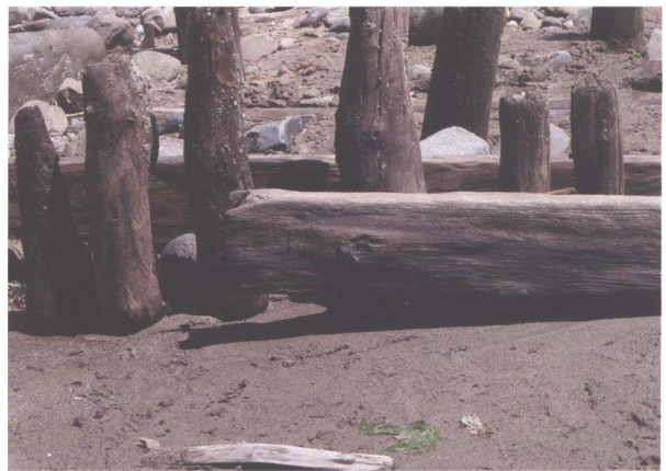
写真3 釘で固定された杭と横板
