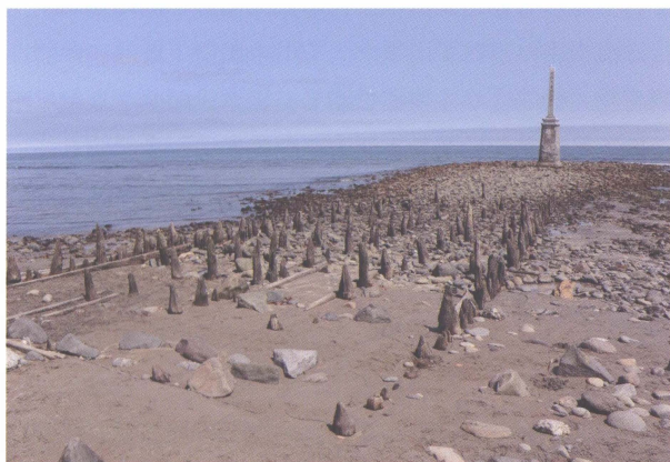
写真7 森栈橋跡に堆積した砂
