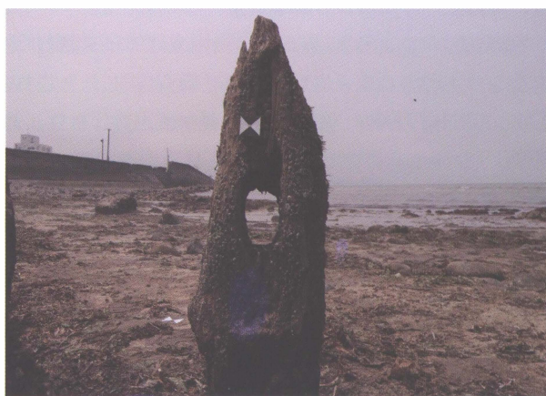
写真9 杭_49 釘による穴
