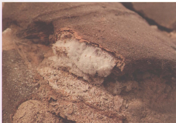
写1 硫酸ナトリウムによる遺跡の破壊
