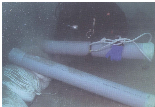
図2 潜水士による埋め戻し作業の様子
