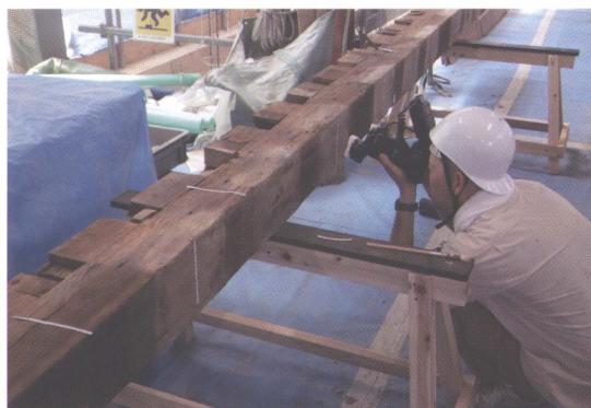
薬師寺東塔での調査
